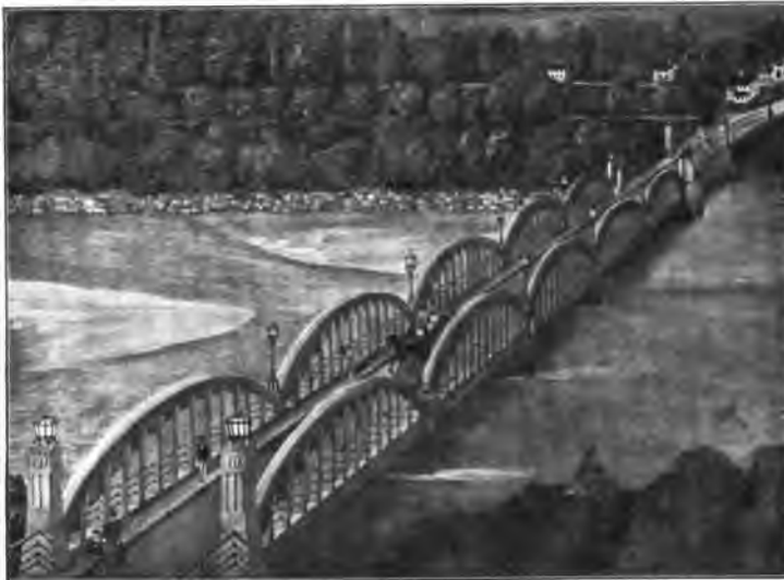
Abb. 91. Brücke über die Bregenzer Ach, Vorarlberg.
